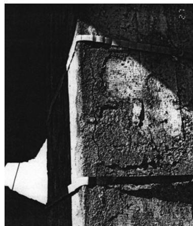
Рис. 2. Скалывание углов стоек рамы
